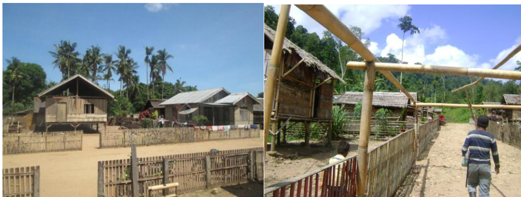
Gambar 2.4. Kondisi Desa Padang dan Dusun Hyong
